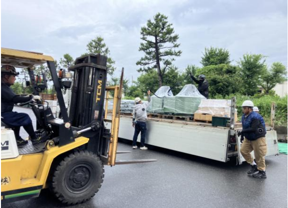
リフトでの資材搬入風景（排気用モーター部材）
