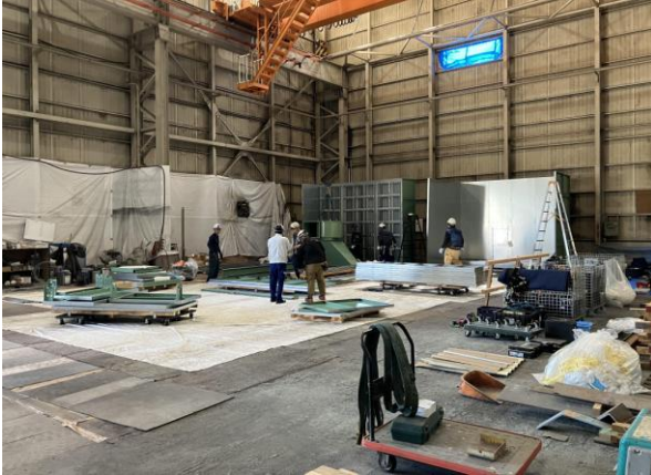
事前作業にてダクト屋外排出用の開口を切除実施 各部材の寸法チェックの上、作業開始！
