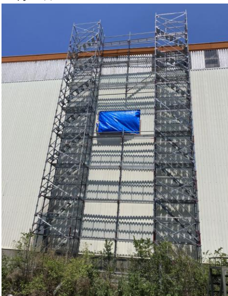
6/13～14の作業にて設置された仮設足場 上部中央の開口部はダクト吐出部箇所 御施主様の責任者が現場確認/視察
