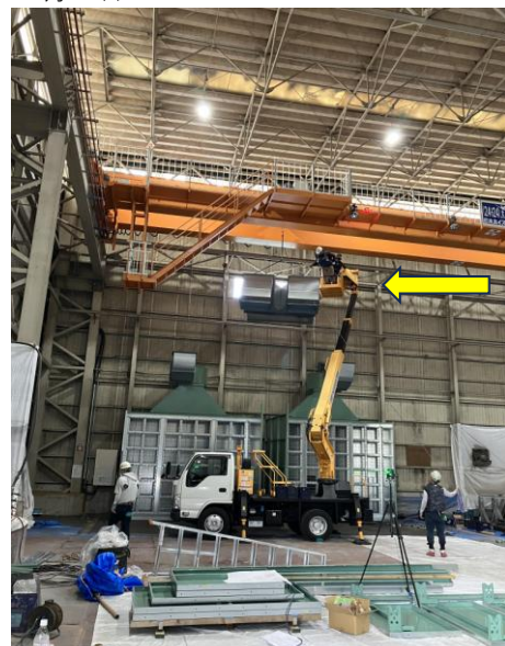
既設ホイスや支柱等が干渉/弊害となり、 屋内作業場で困難を極めるダクト設置作業 協力会社の社長自ら陣頭指揮全般実施
