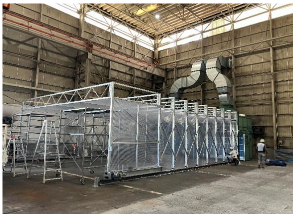
伸縮式ブース用テントの固定（結束）作業
