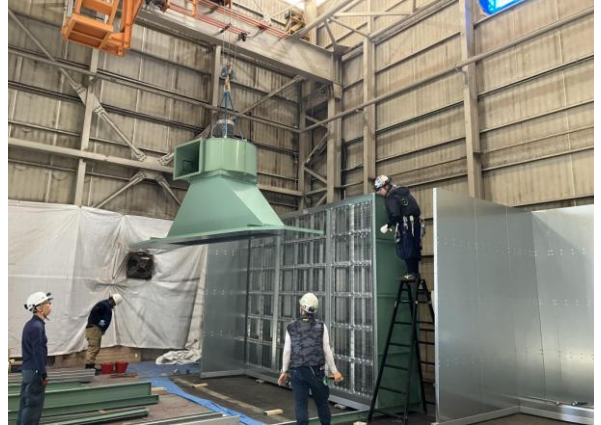
1台目の局所排気装置用のファン装着作業
