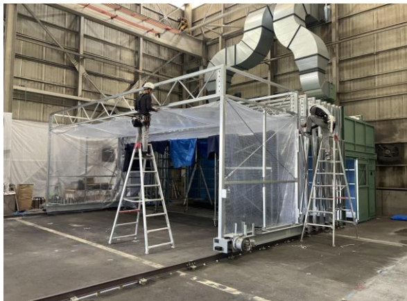
伸縮式ブース用テント設置の作業風景
