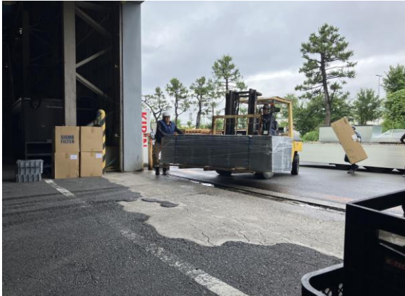
リフトでの資材搬入風景（排気ブース室部材）
