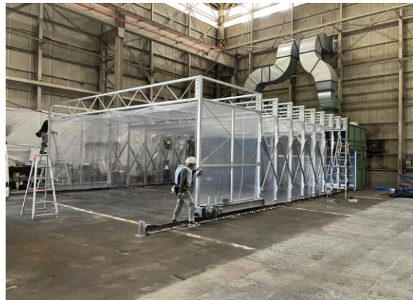
伸縮式ブース用テントの各箇所細部の確認等
