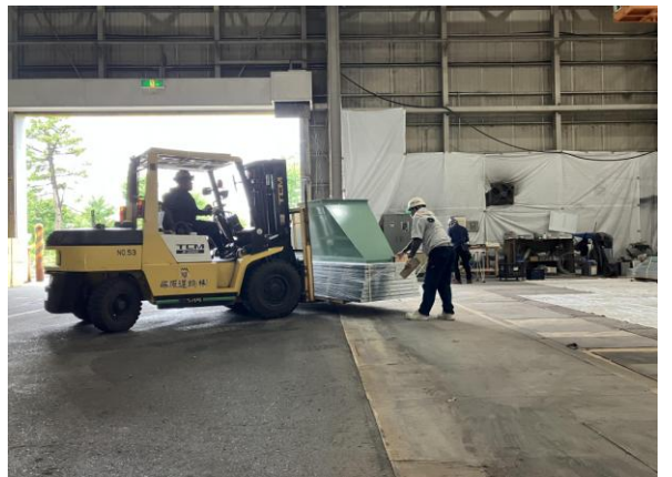
リフトでの資材搬入風景（ダクト関連部材）
