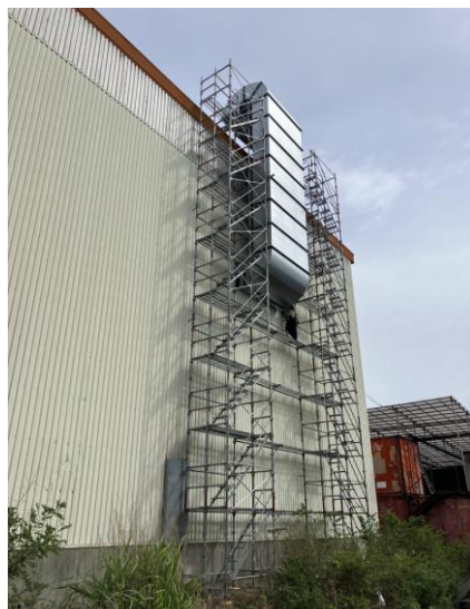
排気用屋外ダクトの設置
