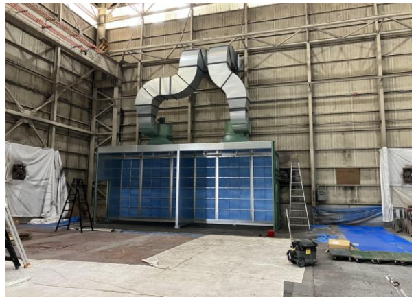
局所排気装置の組み立て完了
