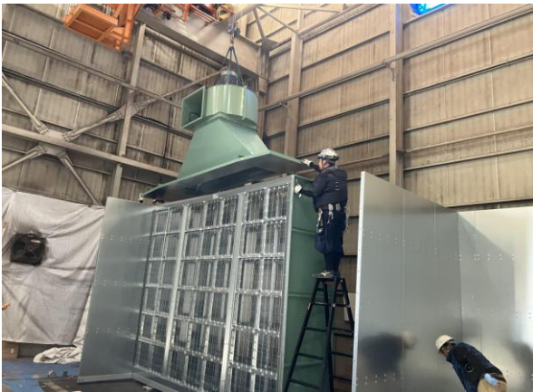
局所排気装置の組み立て作業
