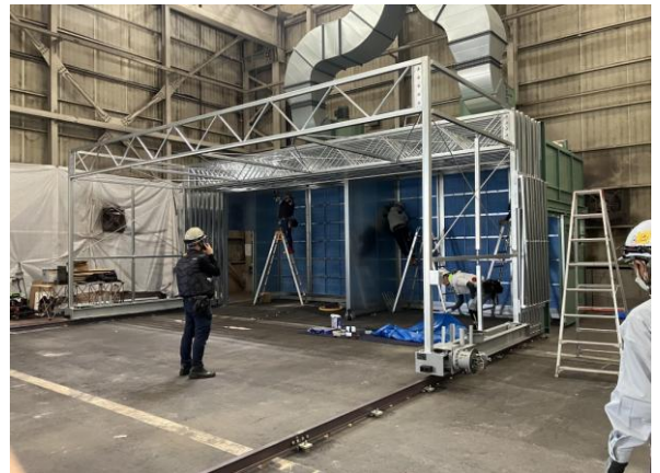
塗装ブースの伸縮動作確認
